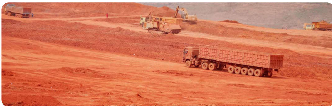
Logistique lourde — acheminement des engins vers les sites.
